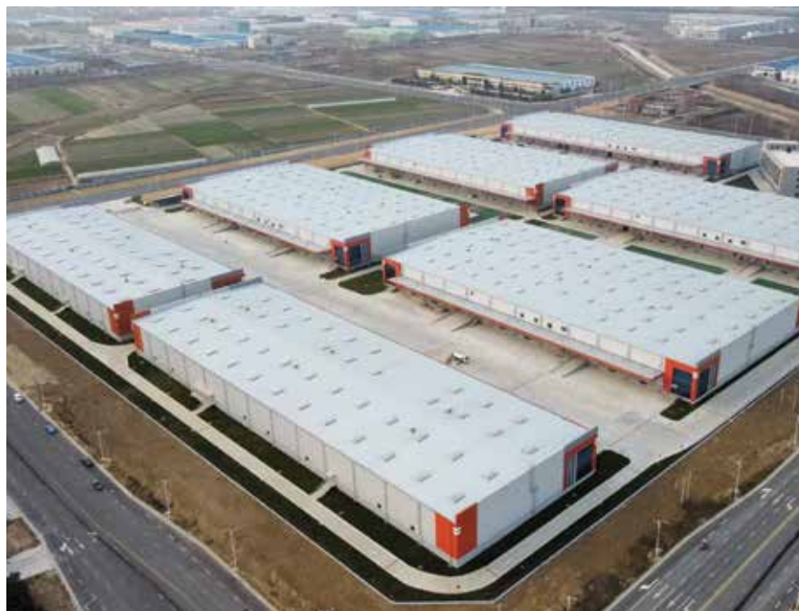
中国河南省にあるMapletree Kaifeng Logistics Park
