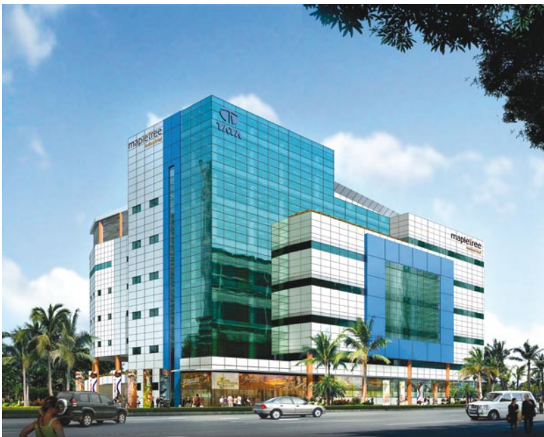
丰树工业基金正在新加坡为塔塔通信国际开发一个量身定制的数据中心。
