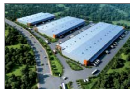
新加坡丰树集团(龙里)综合物流园
