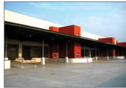
丰树天津空港物流园
