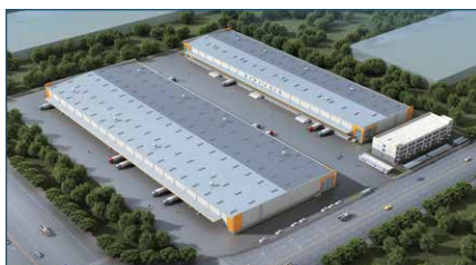
潍坊丰树现代供应链产业园
