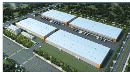
丰树长春经济技术开发区产业园
