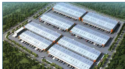
新加坡丰树临海综合产业园
