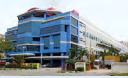
28 521 Bukit Batok Street 23
