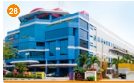
28 521 Bukit Batok Street 23
